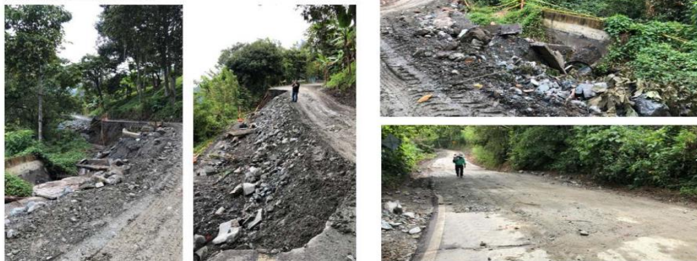
Visita sitio crítico K 26+300
